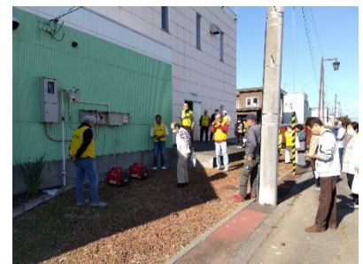
発電機の説明と実演
